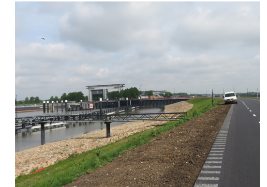
Kruising met het Lekkanaal bij de Beatrixsluizen
