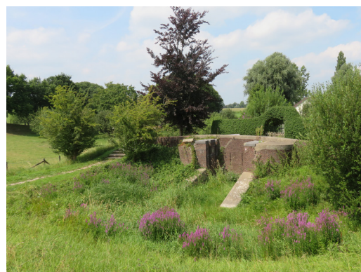
Waterbouwkundig element als aanleiding voor rustpunt
