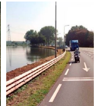
Referentiebeeld van houten geleiderail
