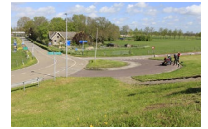
3. Dijkopgang en rust-/verkeersknooppunt bij Schalkwijk
