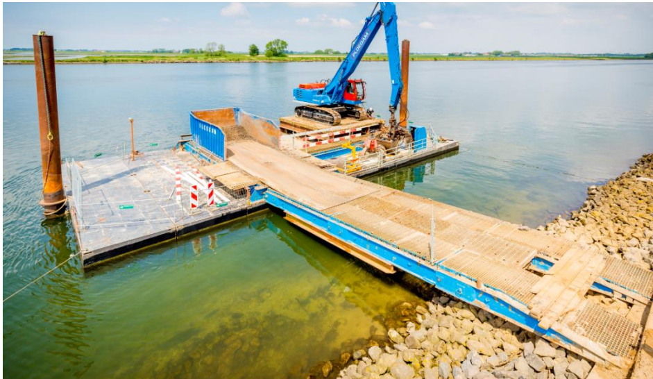
Figuur 5-1: Voorbeeld van een loswal met kraan en brug (Bron foto: Ploegam)
