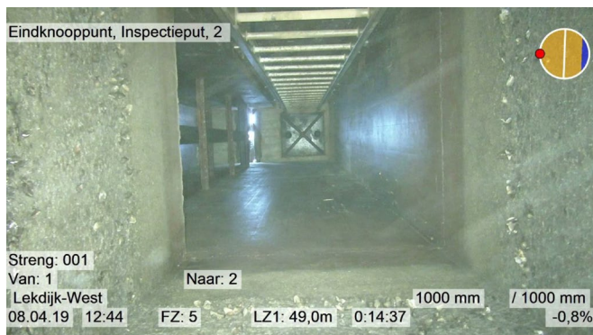
101 102 Figuur 6 Zicht in de schacht vanuit de duiker
